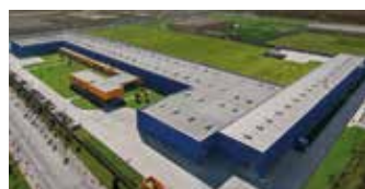
Hörmann Tianjin, Cina
